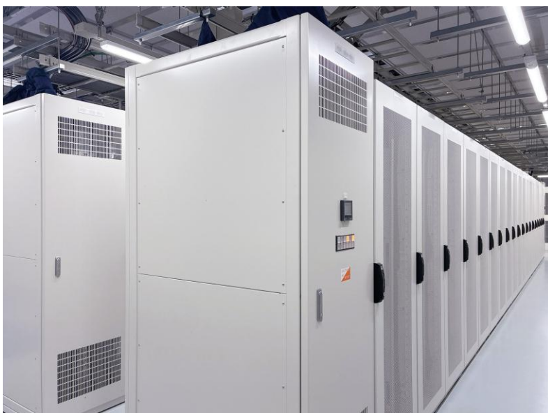
『石狩新港サイト』内部写真
