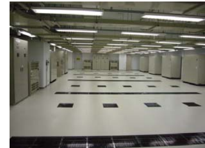
関西サイト内部
